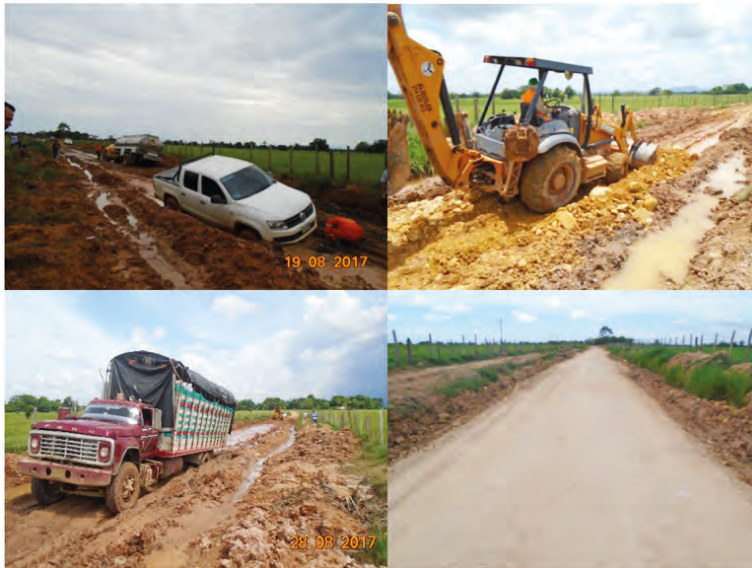
Figura 80. Ejemplo de pasos críticos en vías públicas con pobres especificaciones de construcción. Se observan situaciones de enterramiento de vehículos y trabajos de mantenimiento y mitigación vial desarrollados ocasionalmente por el contratista sísmico en conjunto con las instituciones locales. Se realizan actas de vecindad para documentar el proceso. Fotos archivo personal.
