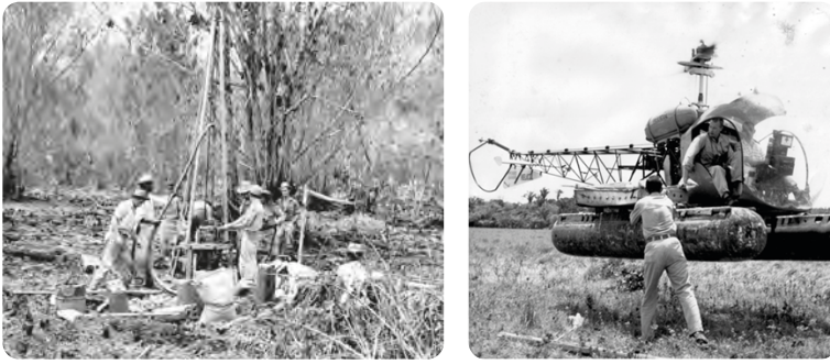
Figura 3. Perforación en un grupo sísmico en el Valle Medio del Magdalena y operación con helicóptero bell 47g, muy utilizado en esa época (fotos archivo personal ing. Henry Melo).
