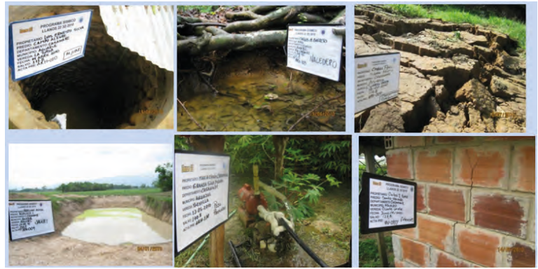
Figura 78. Algunos ejemplos de fotografías anexas a actas de vecindad a elementos sensibles de varios tipos como aljibes, pozos de agua, jagüeyes, nacimientos, procesos erosivos y edificaciones. Fotos de archivo personal.
